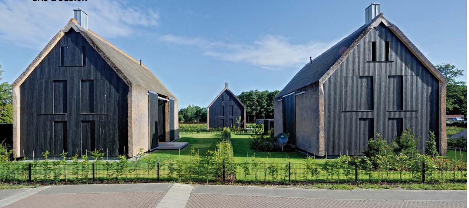
In Prerow auf dem Darß steht das „Scheunentrio“. Von innen und außen ein Hingucker.
