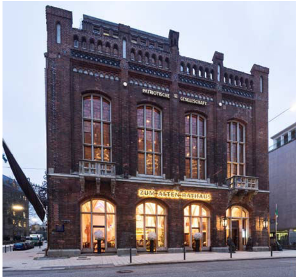
Das Restaurant „Zum Alten Rathaus“ wurde aufwändig umgebaut und neu gestaltet.
