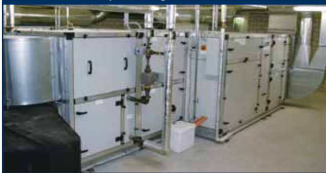
KLIMANAUT 30 – Innenaufstellung im Technikraum
